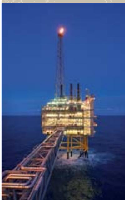
◀ **Plate-forme de forage de Sleipner pour la production de gaz naturel avec séparation du CO<sub>2</sub> qui est réinjecté dans un aquifère salin.**
